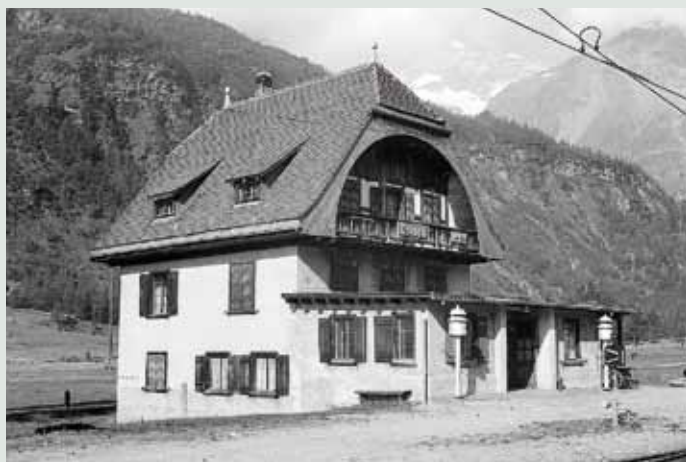
Aus dem Gasthaus mutierte durch einen Anbau zum Empfangsgebäude.
