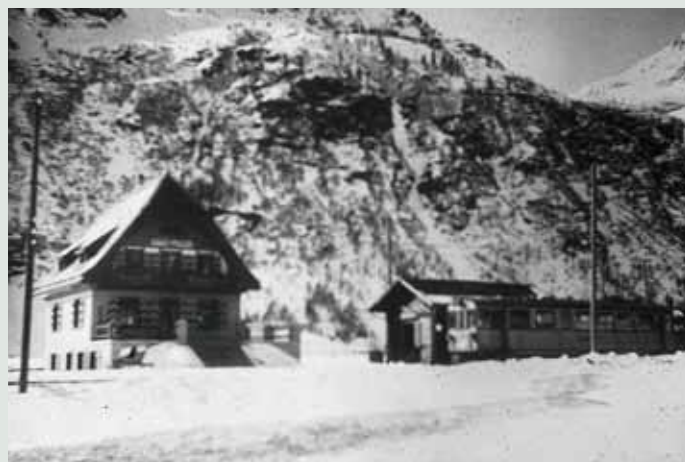
Vor 1923 diente eine Wartekabine neben dem Gasthaus den Fahrgästen.
