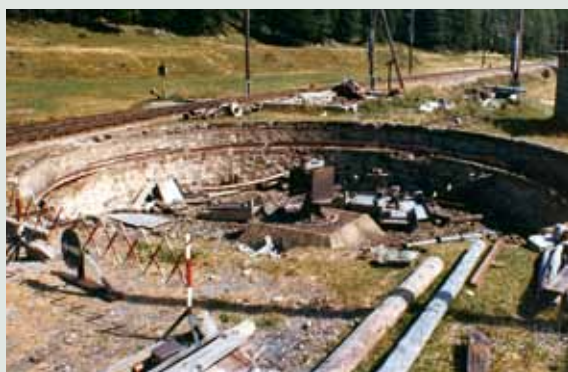
... das Innenleben einer Plattform-Drehscheibe der RhB.
